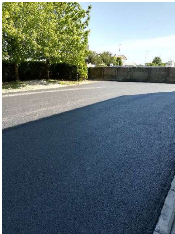
Campo prova al termine della stesa con asfalto modificato con plastiche FV
