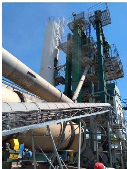
Impianto di produzione asfalto presso IFAF spa
